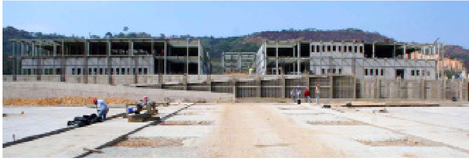
Figura 33 - Hospital prefabricado de 200 camas, con estructura de concreto, en construcción en 4 ciudades, El Vigía, Barinas, San Fernando y Valle de la Pascua. Foto: avance de obra en Barinas, mayo 2013 | Fuente: SCHULTZ, Edzard (2013)
