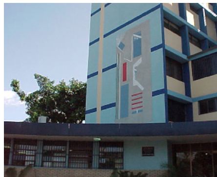
Figura 27 - Hospital Periférico de Coche, Caracas. Remodelación año 2000. Foto: del autor
