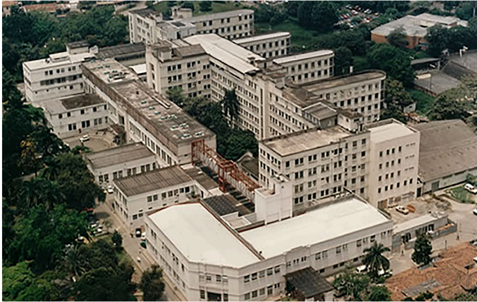
Foto 1 - Hospital Universitario del Valle, "Evaristo García". Cali, Valle
