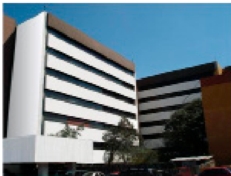
Figura 5 - Hospital Nacional de Puerto Barrios: inaugurado en 1978, post terremoto. construido en forma de lego por furgones. Fuente y diseño: Arq. Victor Cohen
