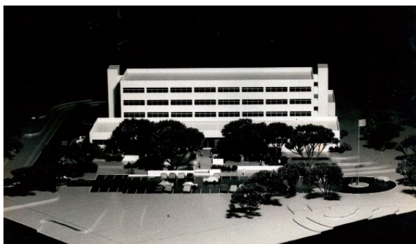
Figura 4 - Hospital Nacional de Puerto Barrios: inaugurado en 1978, post terremoto. Construido en forma de lego por furgones. Fuente y diseño: Arq. Victor Cohen
