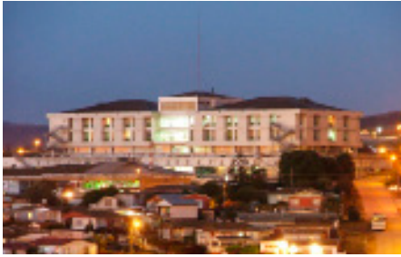
Imagen 14 - Hospital C. Vicuña, San Antonio 1971. Domínguez, Astudillo y Prieto, Arquitectos
