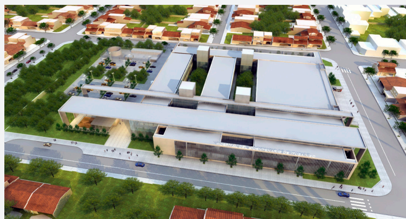
Hospital del Bicentenario de Ituzaingo. Provincia de Buenos Aires
