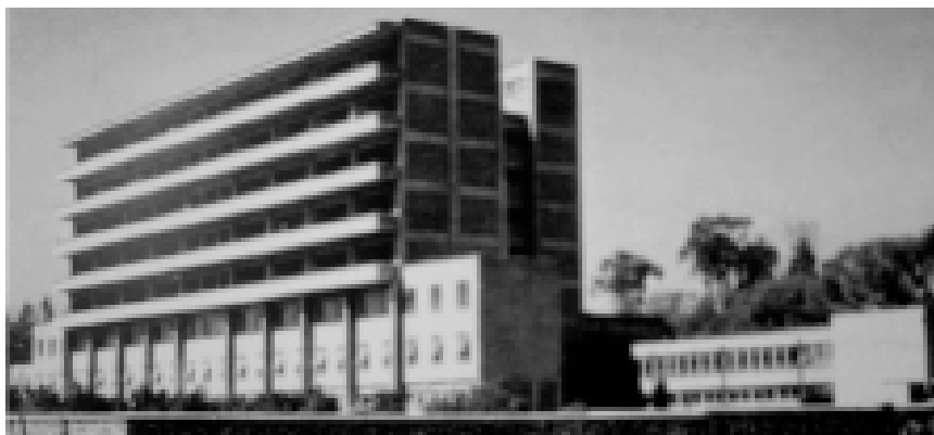
Figura 21 - Fachada original del hospital Manuel Gea Gonzales Fuente: Libro "José Villagrán García vida y obra", Ramón Vargas Salguero, 2005
