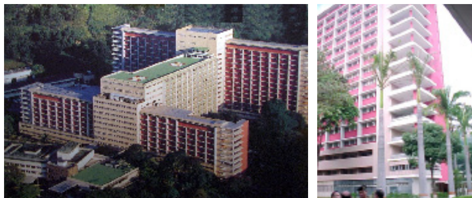
Figura 13 - Hospital militar Carlos Arvelo (1959) Capacidad: 1.000 camas | Fuente: tarjeta postal y foto del autor
