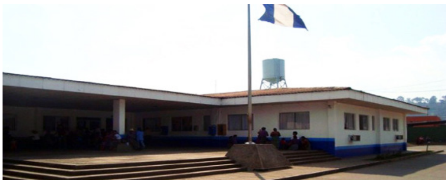
Figura 7 - Hospital Nacional de Chimaltenango Fuente: MSPAS
