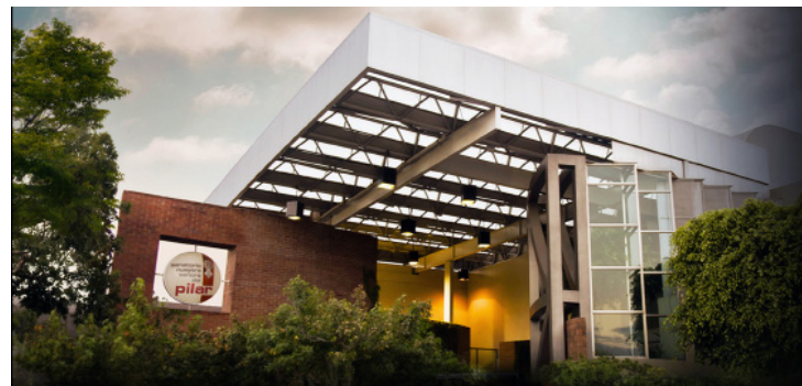
Figura 9 - Sanatorio Nuestra Señora del Pilar: Vestibulo principal de acceso Fuente: Sanatorio NSP
